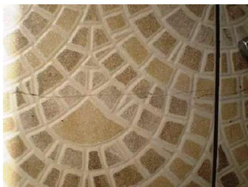
Para evitar este tipo trinca torna-se necessário utilizar juntas de movimentação e juntas de dessolidarização / união.
